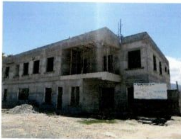
Levantado de muros en perímetro de losa fundida.
