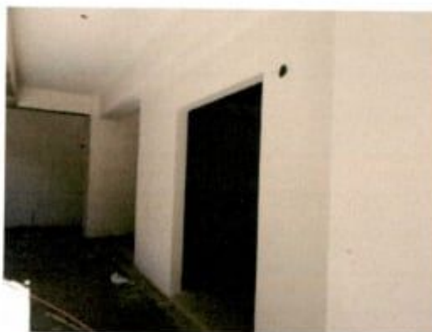
Acabados interiores primer nivel FRAGUADO DE LOSA
